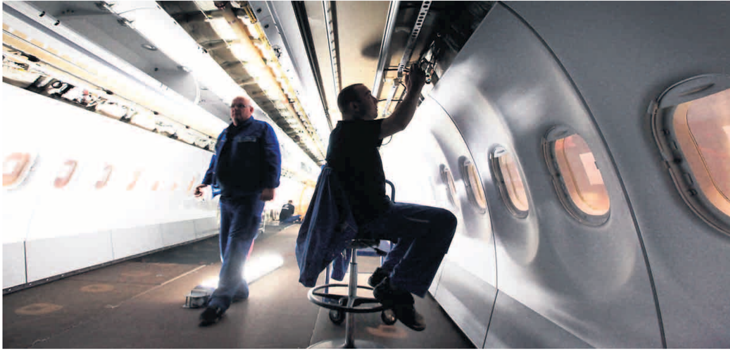
Ein Blick in die 34 Meter lange, noch leere Kabine eines Airbus A321. Später werden hier 200 Passagiersitze eingebaut. An der Decke sind Kabelstränge und Rohre der Klimaanlage sichtbar. Fotos: Roland Magunia
