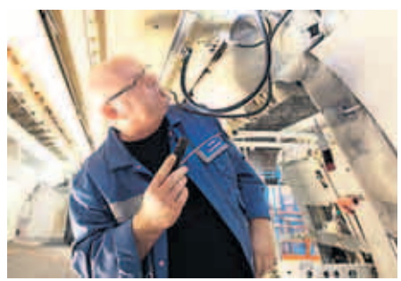
Ein Techniker prüft die Kabinenelektrik. 300 Kilometer Kabel stecken in dem Jet
